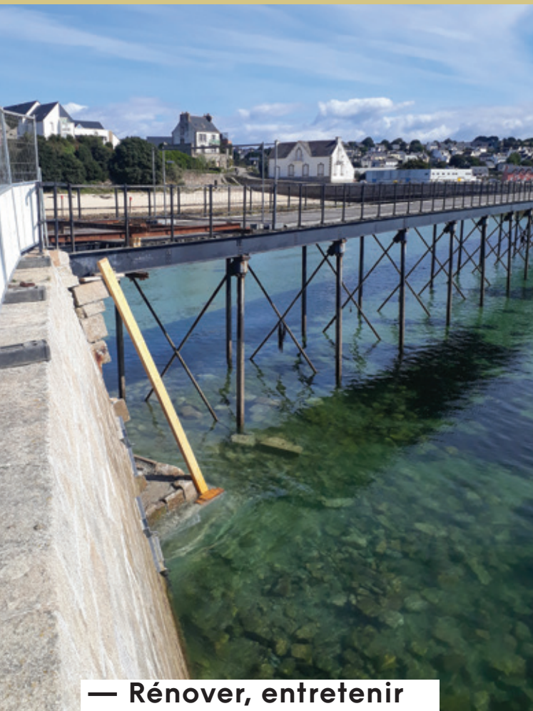
Ci-contre : Rénovation de la passerelle des Capucins.
